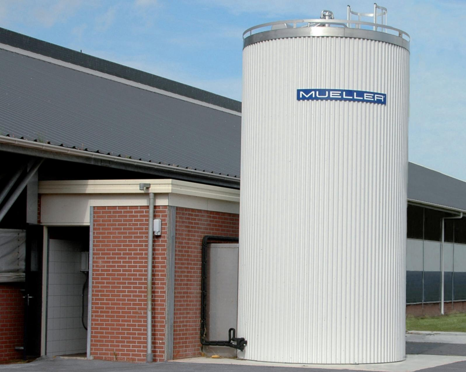
Ein Silotank spart Platz, wodurch Sie günstiger bauen können. Ein Silotank ist jedoch oft teurer. Die Wahl zwischen einem liegenden Tank oder einem Silotank hängt vom vorhandenen Platz und dem Stallentwurf ab.
